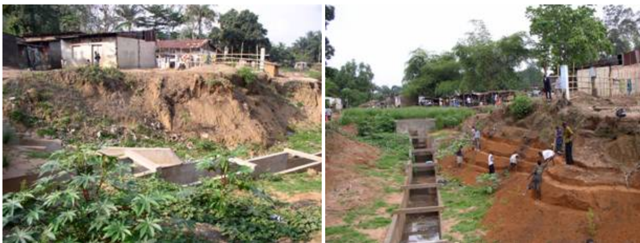
A cabeceira da voçoroca que ameaçava a cidade. A figura a direita mostra a cabeceira da voçoroca já estabilizada com vetiver e a encosta começando a ser preparada para o plantio.
