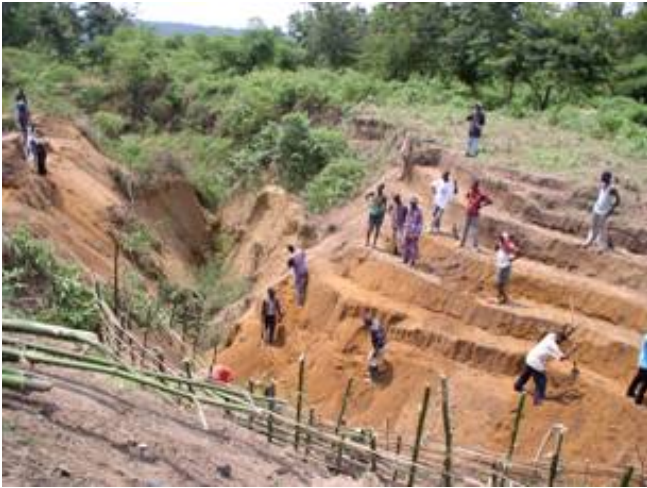
A esquerda preparação da encosta, e a direita o produto final depois de 4 meses com Alin Ndona (direita do sinal) que trabalhou com a comunidade nesta recuperação de voçoroca.
