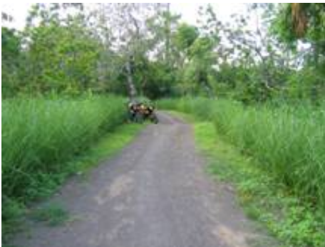
El camino fue mejorado y estabilizado con vetiver (izquierda), tal como las casas de las villas (centro). Jardines orgánicos estabilizados usando vetiver como práctica de conservación del suelo y del agua y para mulching (derecha).
