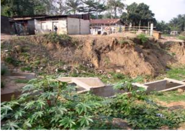
L'extrémité supérieure du ravin menaçant la ville. L'image du côté droit montre la tête du ravin déjà stabilisée avec le vétiver et les pentes étant préparées pour la plantation.
