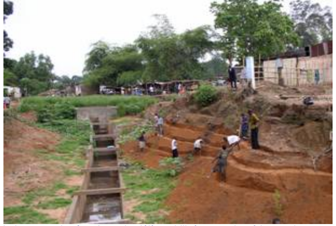
L'extrémité supérieure du ravin menaçant la ville. L'image du côté droit montre la tête du ravin déjà stabilisée avec le vétiver et les pentes étant préparées pour la plantation.
